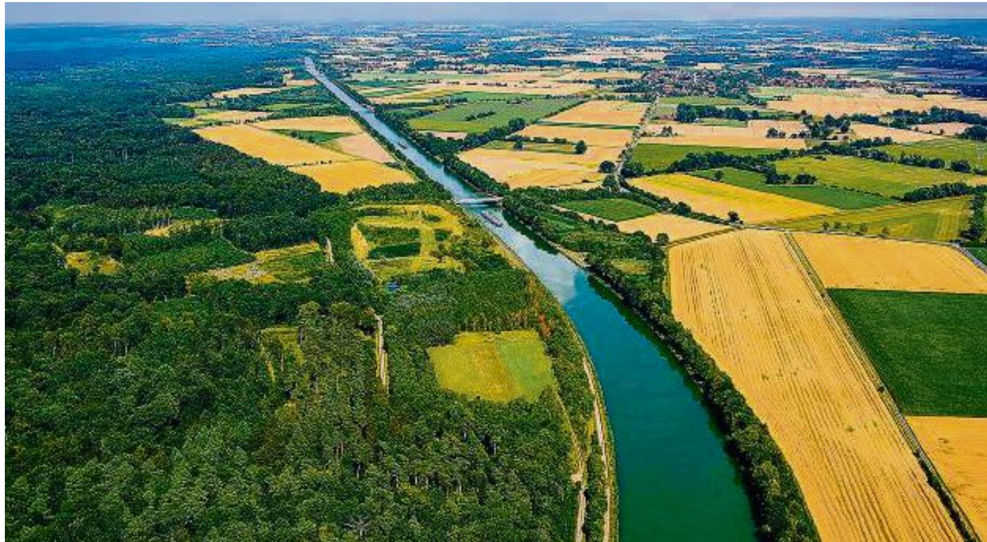
Der Mittellandkanal zieht sich durch vier Samtgemeinden. In Sachen Bahntrasse sind die Anrainer äußerst skeptisch.
